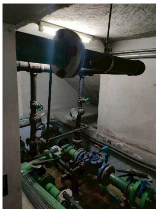
รูปที่ 37 ระบบเส้นท่อประปา
